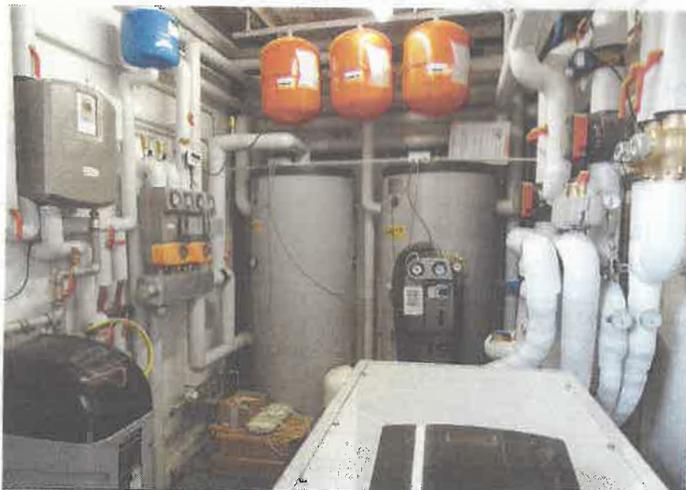
Il locale che ospita lo scambiatore di calore che ha sostituito la caldaia
